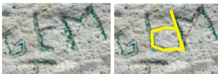
Détail comparatif de la photo page 58 – Mise en évidence du d minuscule et de la fissure
